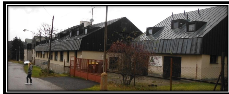
Pohled na areál zvenčí
